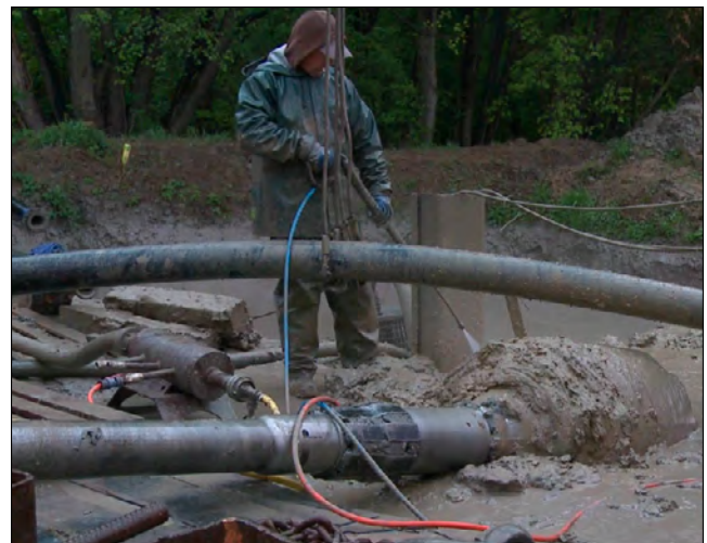
Fot. 6. Końcowy etap montażu rury gazowej w metodzie przewiertu HDD Pic. 6. The final stage of gas pipe assembly, the HDD drilling method
