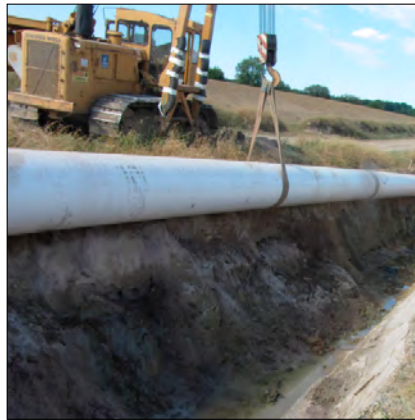
Fot. 2. Opuszczanie rury gazociągu do wykopu Pic. 2. Lowering the gas pipeline into the trench
