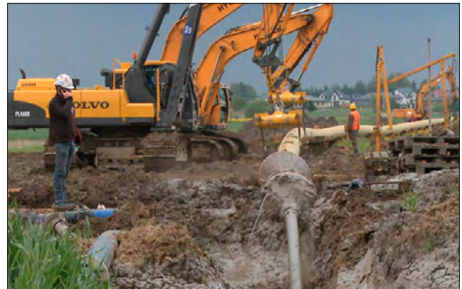
Fot. 5. II etap montażu - rozwieranie z wciąganiem rury gazowej w metodzie przewiertu HDD Pic. 5. Stage II of the assembly - reaming with pulling of the gas pipe in the HDD drilling method
