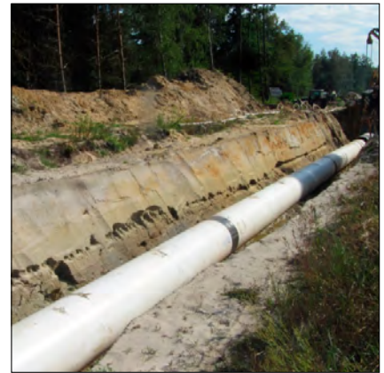
Fot. 3. Rura gazociągu ułożona w wykopie Pic. 3. Gas pipeline laid in a trench
