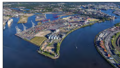
Rys. 11 Oczyszczalnia ścieków Köhlbrandhöft w Hamburgu (źródła: https://www.hamburg.de ; https://www.luftbildsuche.de ) Fig. 11 Köhlbrandhöft sewage treatment plant in Hamburg (source: https://www.hamburg.de ; https://www.luftbildsuche.de )
